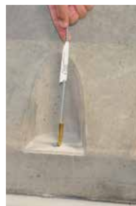
Bild 5d Bohrung ausbürsten
