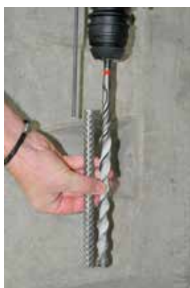
Bild 5a Bohrtiefe einstellen
