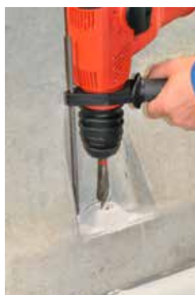
Bild 5b Befestigungslöcher bohren
