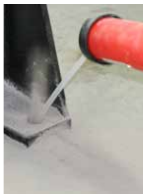
Bild 8c Bohrloch ausblasen
