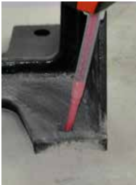
Bild 9a Verbundmörtel füllen
