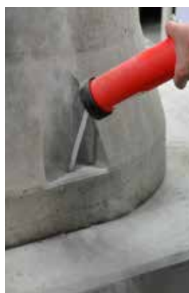
Bild 5c Bohrung ausblasen
