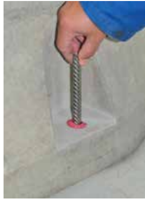
Bild 6b Bewehrung einsetzen
