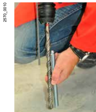
Bild 8b Bohrtiefe einstellen
