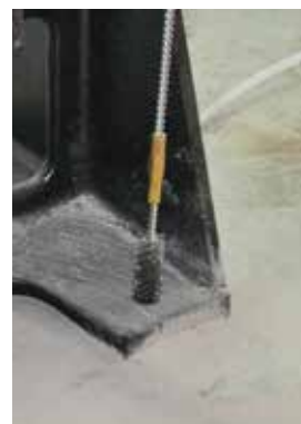
Bild 8d Bohrloch säubern
