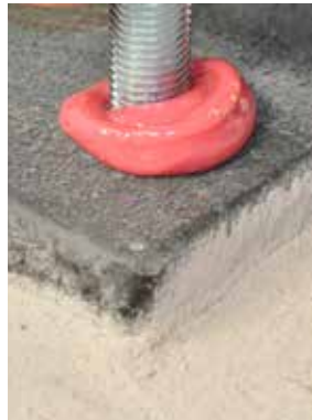
Bild 9b Stift einführen
